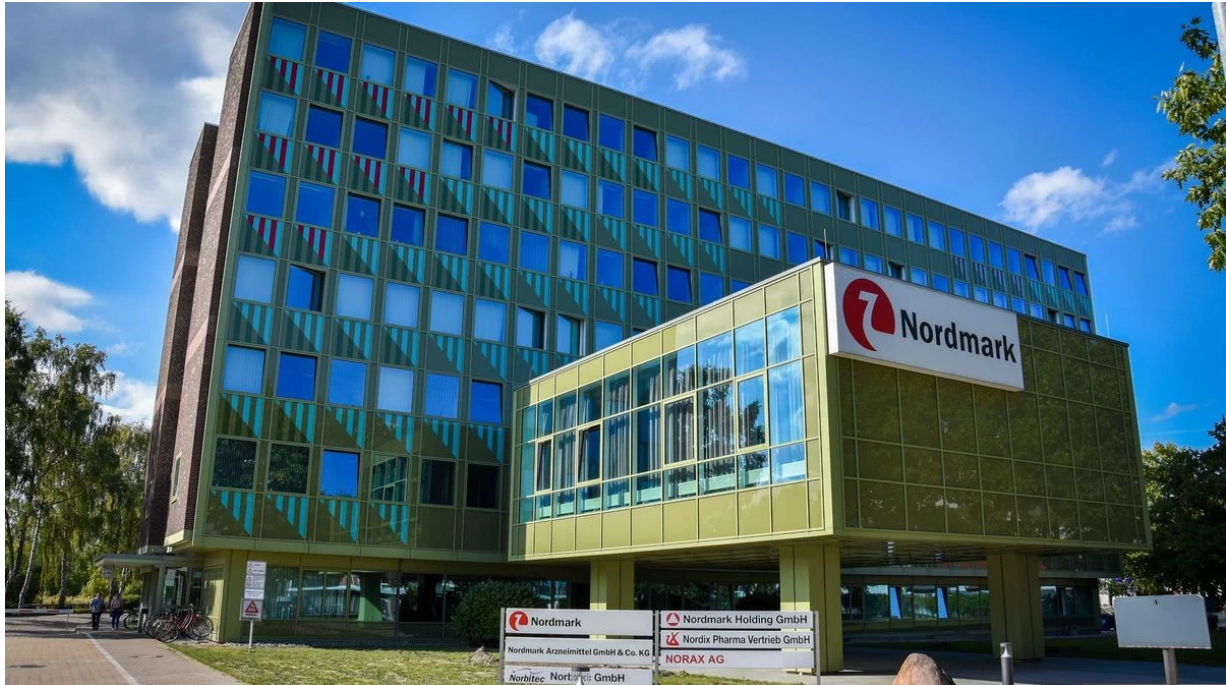
Das Hauptgebäude des Pharmaunternehmens Nordmark in Uetersen
