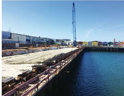
Bilder von links nach rechts: Montage der oberen Gleitleisten am Betonholm im Bereich. Fertigteilmontage, Blickrichtung Westen.
