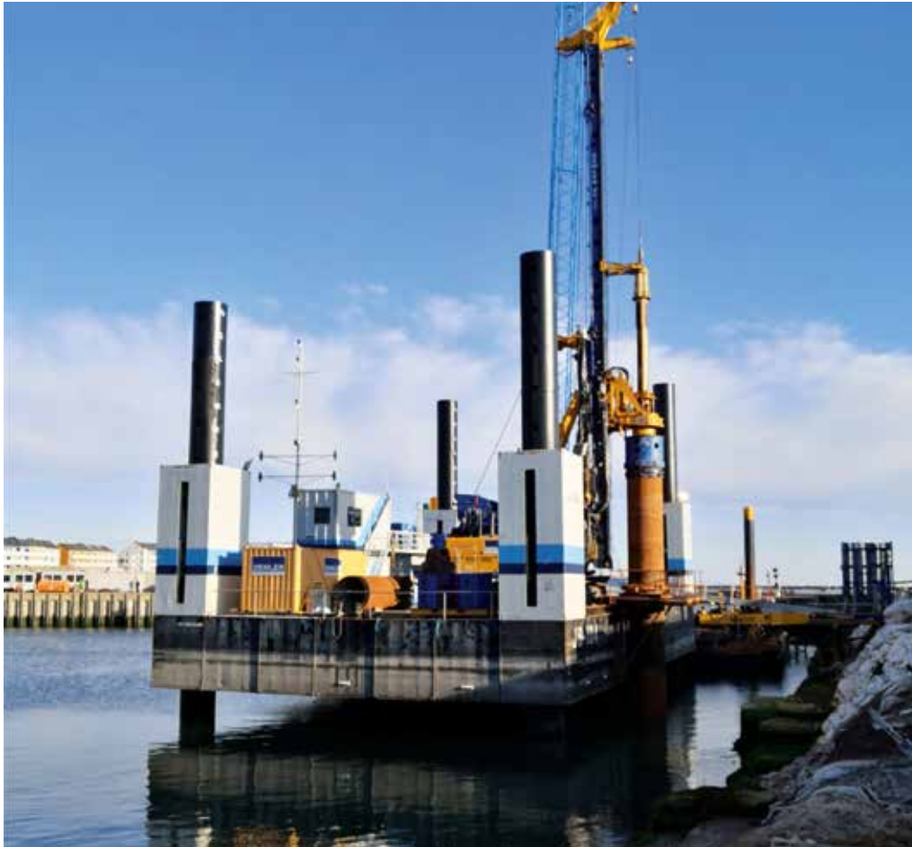
Hubinsel mit Bohrgerät am Südostufer
