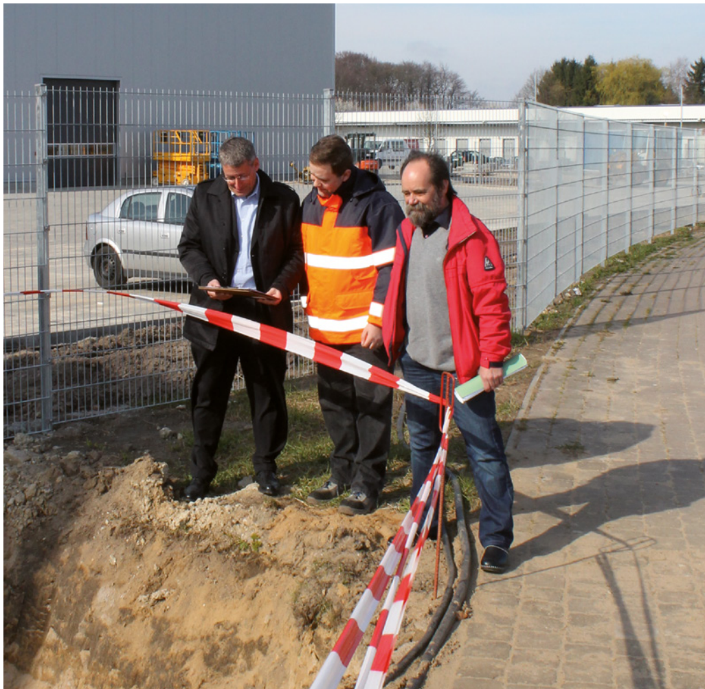
Gewerbegebiet Tornesch: Baubesprechung mit Vertretern der Stadt Tornesch und dem ausführenden Bauunternehmen im BusinessPark Tornesch
